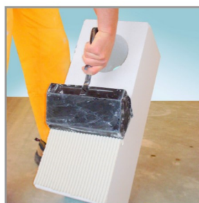
Le mortier-colle est prêt à l'emploi
