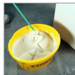
Malaxer le mélange mortier + eau
